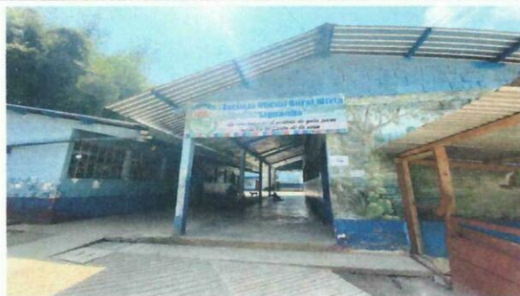
Foto 3, cambio de piso en los módulos
