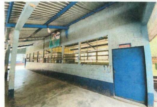
Foto 4: mantenimiento de pintura en el instituto-
